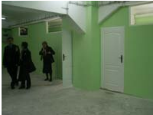
Lavori in corso a marzo 2008
