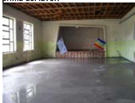
La gettata per il pavimento
