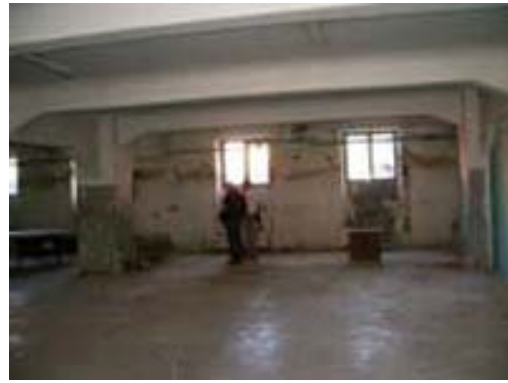
Lavori in corso a settembre 2007
