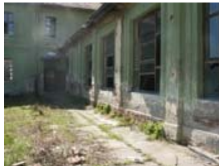
Interno ed esterno del locale prima dei lavori
