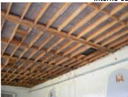
Il tetto dall'interno: lavori ultimati
